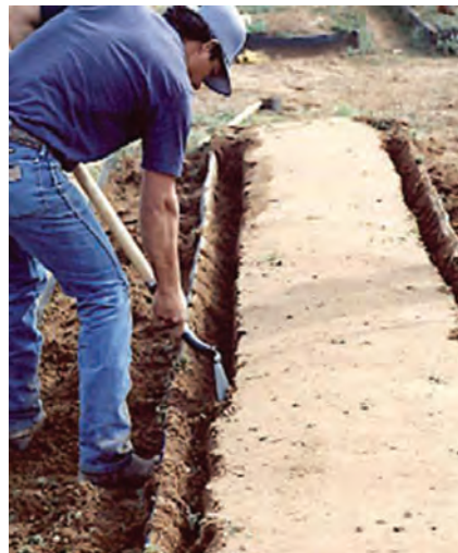
Слика 3. Рачно поставување на полиетиленски фолии
